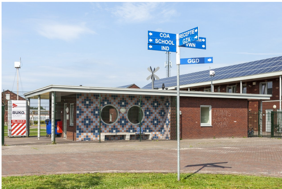
Terrein aanmeldcentrum in Ter Apel
